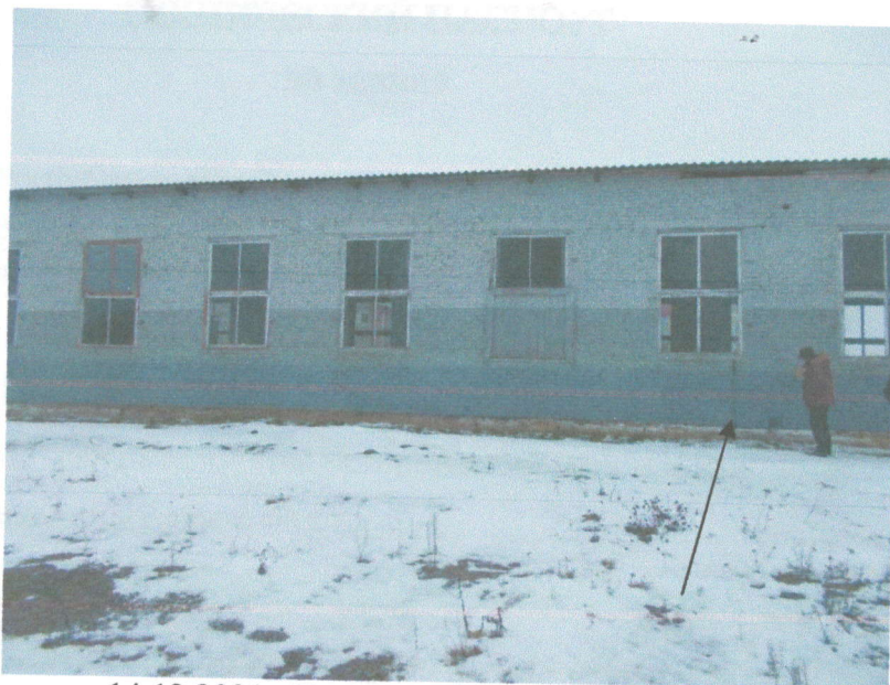
14.12.2021г Литер в- Сеть электроснабжения (по стене здания ул. Коммунистическая, 47/7)
